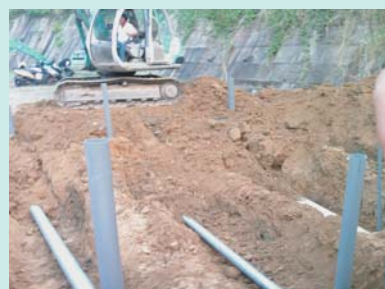
圖3 檢測場地下埋管設置
