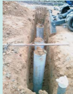
圖9 檢測場基樁埋設情況
