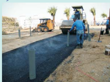
圖6 檢測場AC鋪設壓實情形
