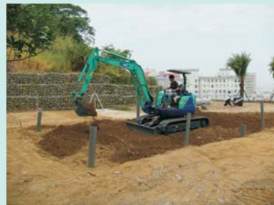
圖2 檢測場施工狀況
