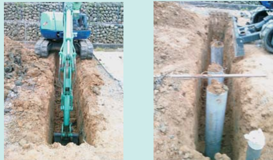
圖8 檢測場基樁埋設開挖施工狀況
