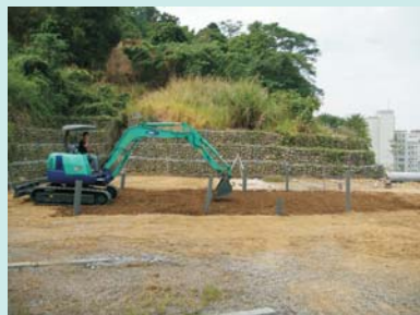
圖4 檢測場級配回填施工
