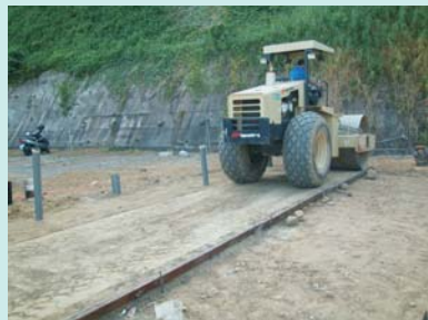
圖5 檢測場壓路基滾壓情形
