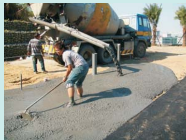
圖7 檢測場PC鋪設壓實施工情形
