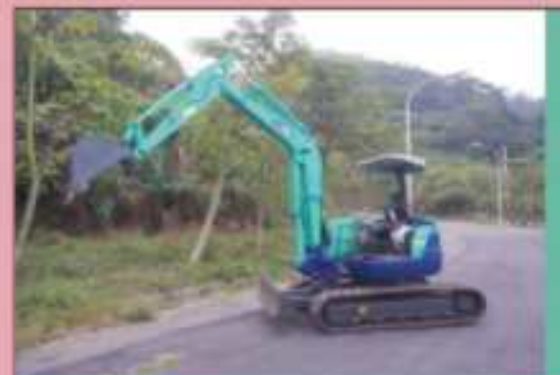
三一挖土機兼破碎機
