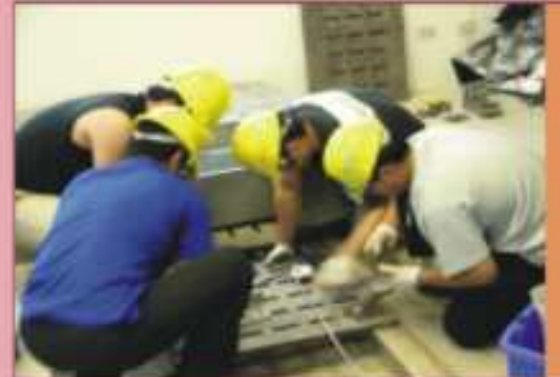
裝設鋼構地板
