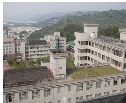
圖 6.2 屋頂隔熱系統
