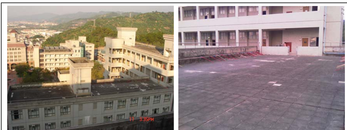
圖 1 本計畫預計改善地點現況
