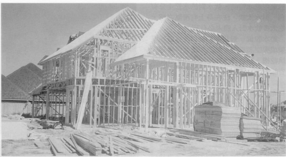
同一住宅在施工過程中：(a) 屋架工程
