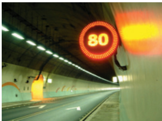
雪山隧道內最高速限為80km/hr。如因突發狀況而需調整速限時，「速限可變標誌」將顯示出當時的最高速限。
