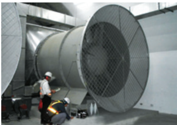
軸流式風機測試：為了確保隧道營運時的空氣品質及有效導排火災發生時的濃煙，故通車前的風機測試不可不慎。
