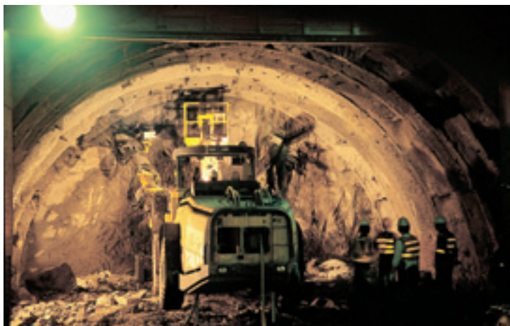
鑽炸法利用機械化鑽堡進行鑽孔作業之情形
