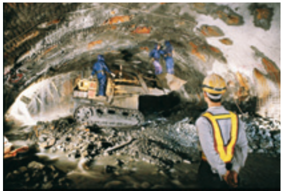
雪山隧道導坑通過斷層破碎帶時的施工情形。
