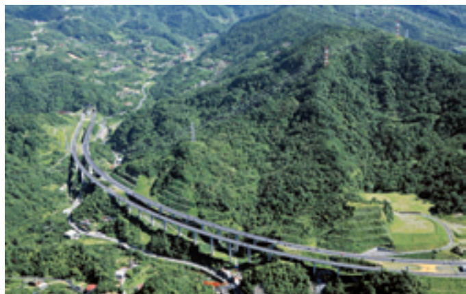
彭山1號高架橋，是臺灣目前最長的無伸縮縫連續梁橋（無縫段長度達617m），不僅是國內橋梁工程首見，更大幅提高了行車的舒適性及平穩性。
