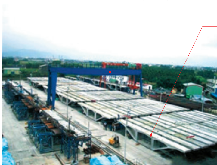
利用預鑄場中的天車，將預鑄節塊吊放於拖車上，再運送至施工現場。
