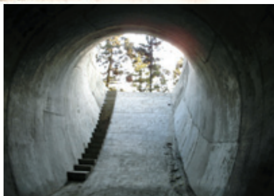
1號豎井排氣井所連結的水平排氣隧道出口
