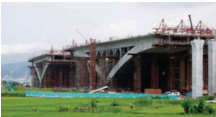
拱橋基座採用場鑄現地支撐的方式施作；拱座範圍外則採用場鑄懸臂工法。
