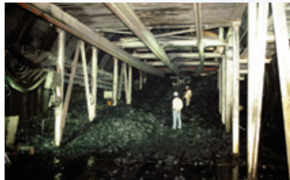
北上線26.78K TBM內抽坍情況
