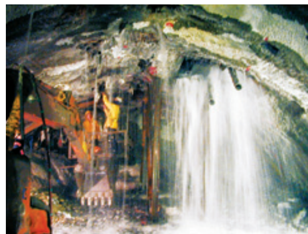
雪山隧道北上線22K附近的施工中湧水情形。
