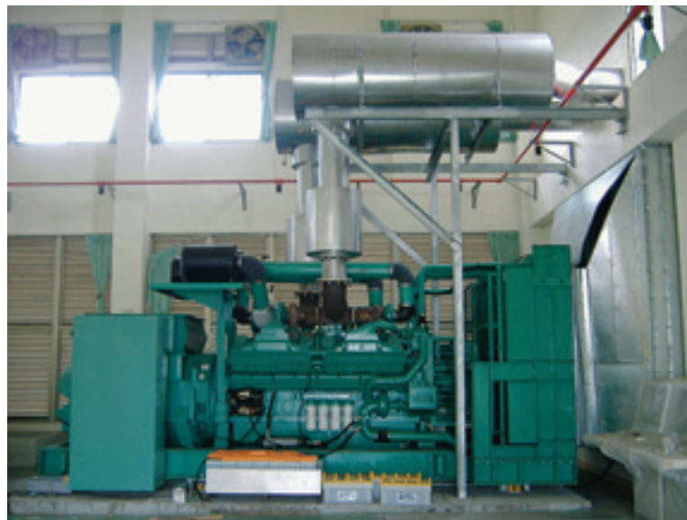
雪山隧道於坪林及頭城兩端均設有「緊急發電機」，可供停電時緊急照明之用。
