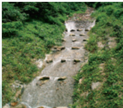
坑子口溪沿線支流的溪床固床工。
