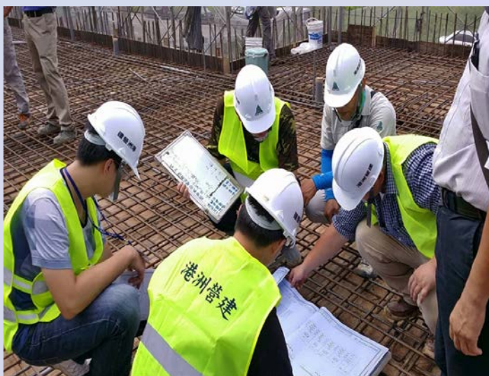
圖 2 校外暑期實習-現場鋼筋查驗
