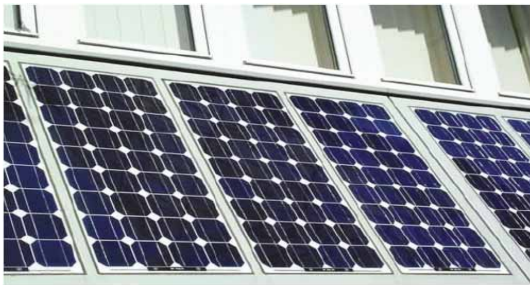
建築物在設計時，就把太陽能收集板考慮在內，不影響外表的景觀，也可以提供所需的能源。
